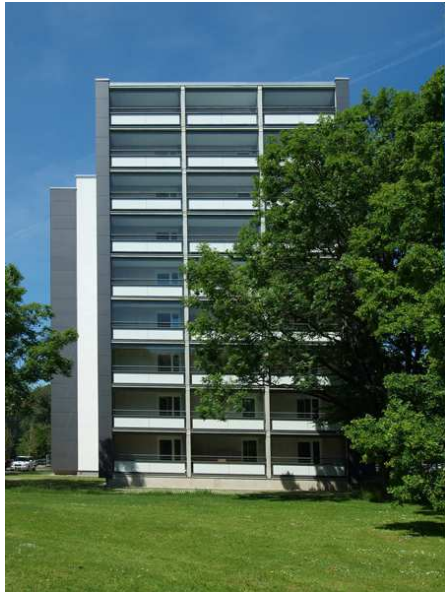
Pertisastr. 7 als Erweiterung für Wohnen im Viertel Berg am Laim
